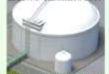
水素受入基地の整備(大型液化水素貯蔵タンク)
