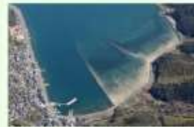
浚渫土砂を活用した干潟の造成(徳山下松港)
