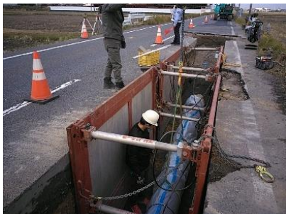
送水管布設替工事の施工例
