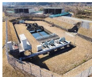
浸水対策予定の施設 （高野取水施設）
