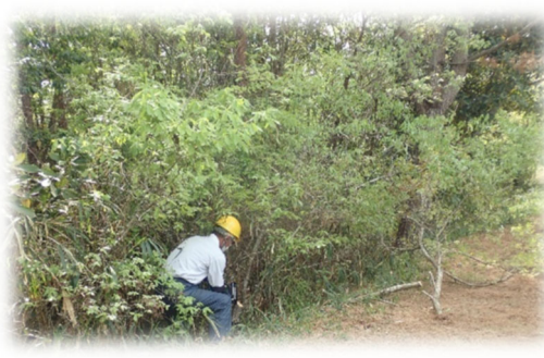
歩道沿い除伐状況
