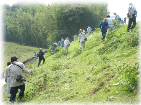
ため池法面の草刈り作業
