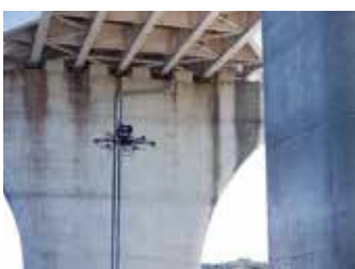
ドローンによる点検
