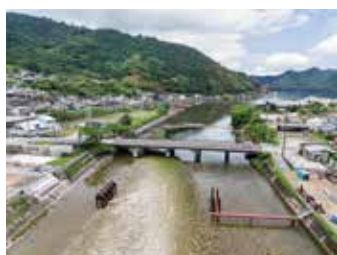
⑯国道 311 号(尾鷲市)
