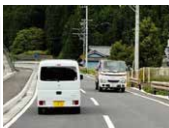
⑲国道 368 号(津市)
