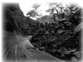
平成 23 年紀伊半島豪雨(熊野市)
