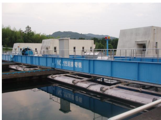
更新予定の多気浄水場沈澱池汚泥掻寄機
