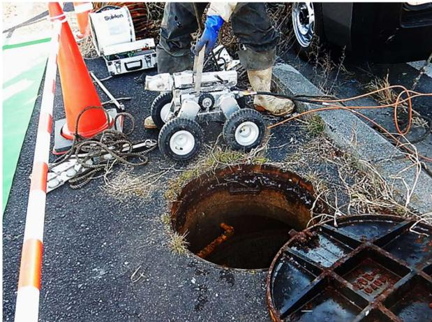
自走式カメラによる管渠内部点検
