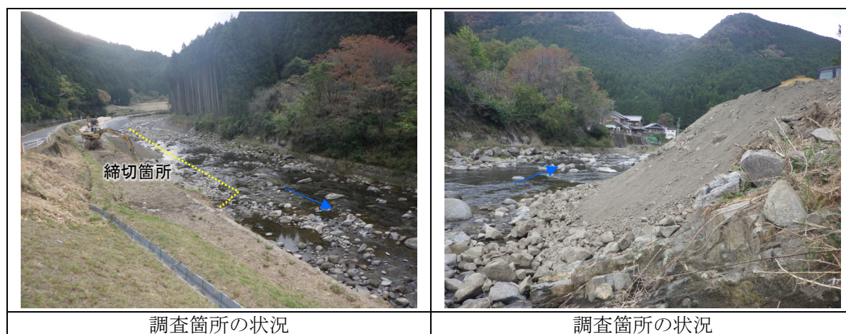
図 5.2-1 調査箇所の状況（工事直前：令和5年11月6日）
