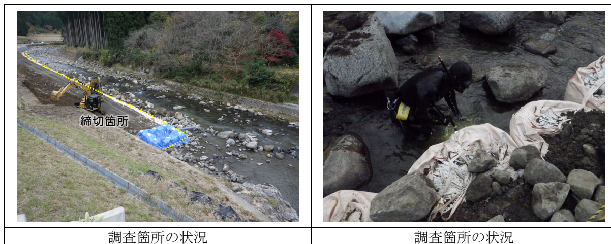
図 5.3-1 調査箇所の状況（工事着手後：令和5年11月29日）
