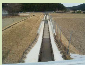
(農業用排水路)
