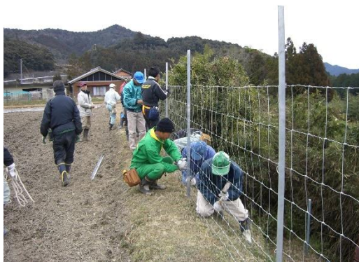
侵入防止柵の設置
