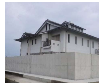
三渡川ポンプ場の防潮壁
