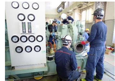
下水処理設備の点検状況
