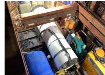
内宮幹線管渠延伸工事
