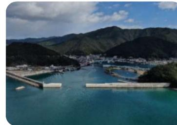
南海トラフ地震等の大規模自然災害による高潮・波浪・津波に備えるため、防波堤の嵩上げや耐震・耐津波対策に取り組みます。
