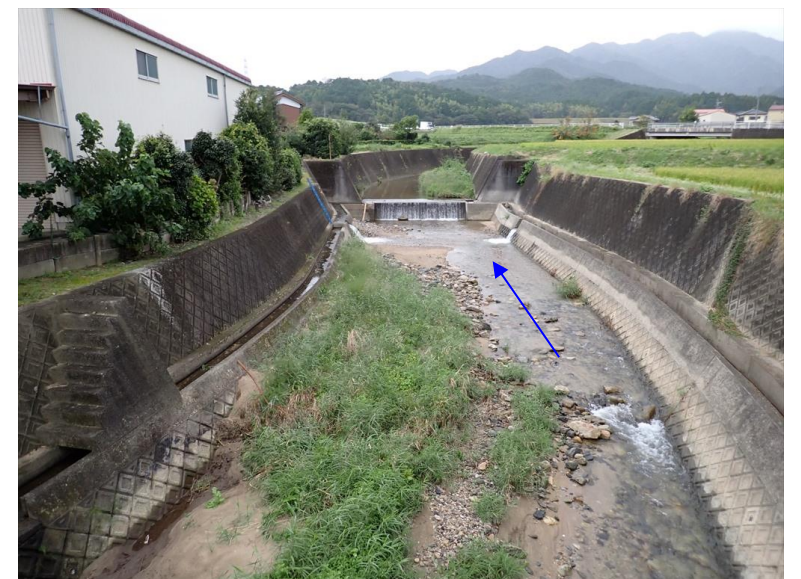
上流端から下流方向
