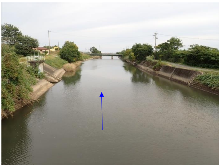
巡見橋から下流方向
