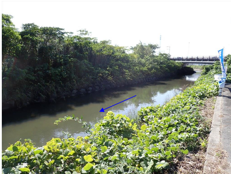
中川橋から上流方向
