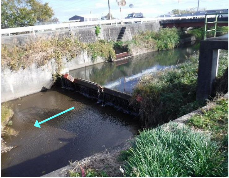
此亦(しまた)統合堰(堀坂川2.3k付近)
