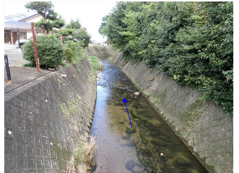
上流端から下流方向
