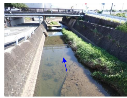
三渡川 三蔵橋下流 (上流部)
