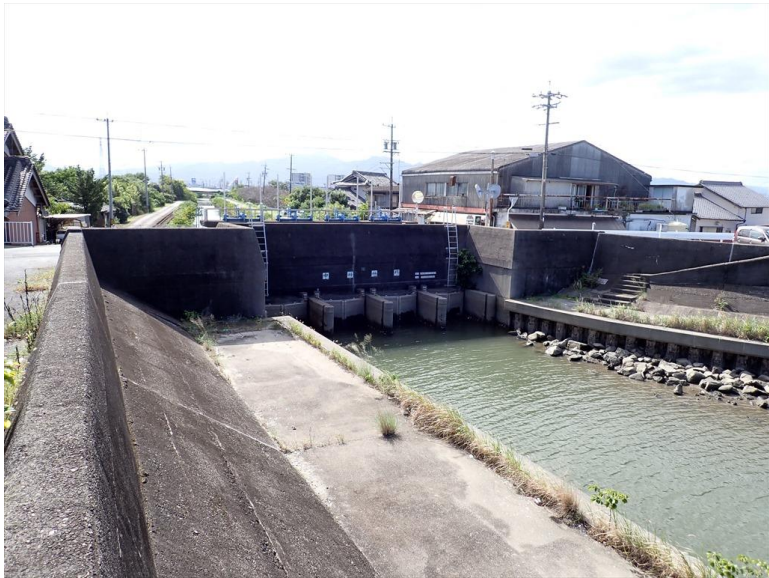
下流端の水門
