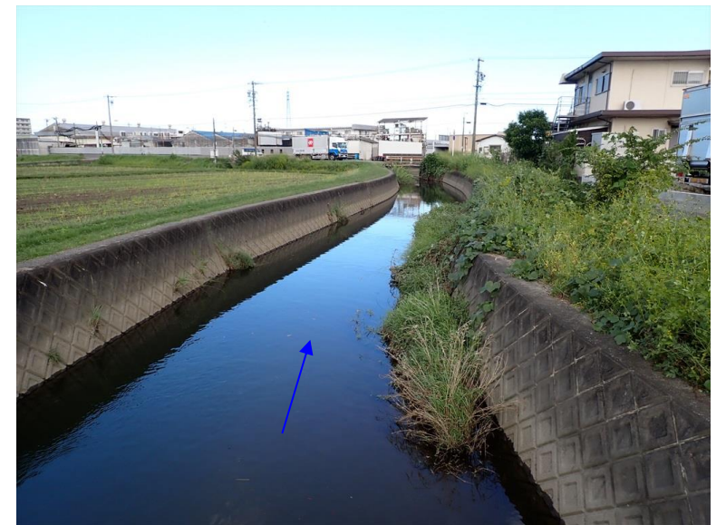
県管理区間上流端から下流方向
