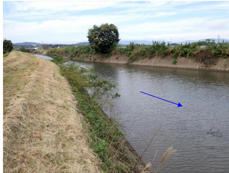
岩内川合流点から上流方向
