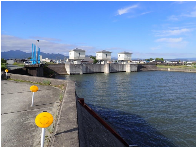
下流端の水門
