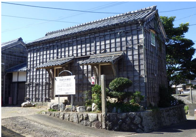
毀損前（東から）
