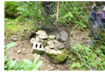
樹脂メッシュと石で補修
