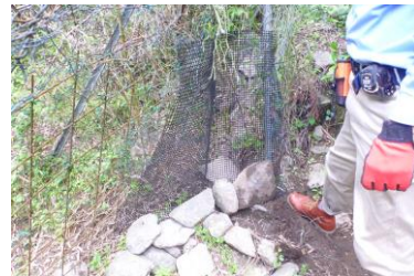
樹脂メッシュと石で補修
