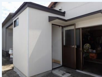
シャワーの設置
