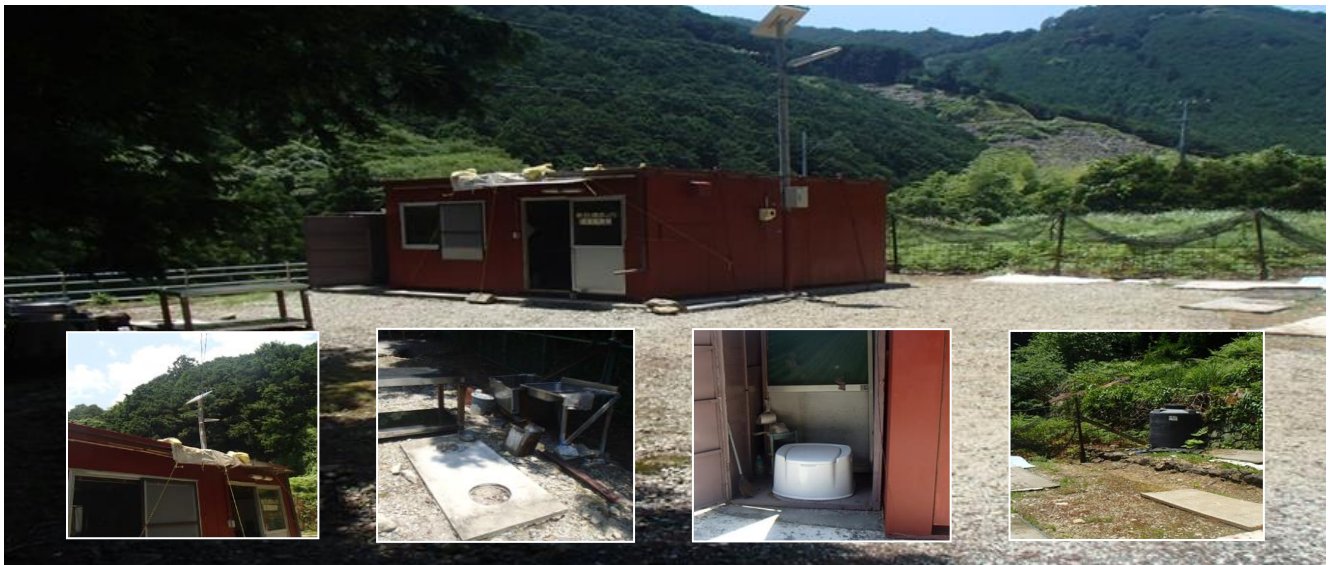
地域住民自ら整備した避難所（ソーラーパネル、炊き出し用コンロ、簡易トイレ、飲料水の確保）
