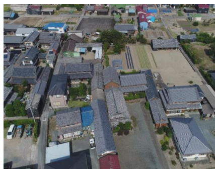
ドローンによる被害状況偵察
