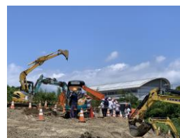
建設重機の体験乗車
