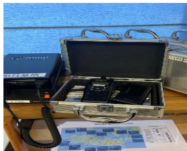
防災無線の整備
