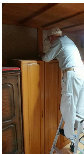
家具固定器具の取付
