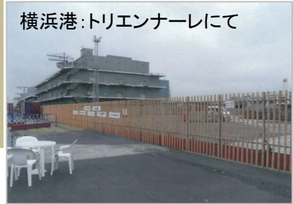
進入ガード製作
