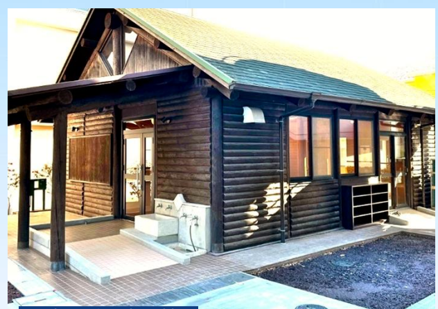
造形活動実習棟 (外壁塗替え等)
