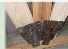
土台・柱部分に設置された補強金物
