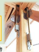
梁・柱部分に設置された補強金物
