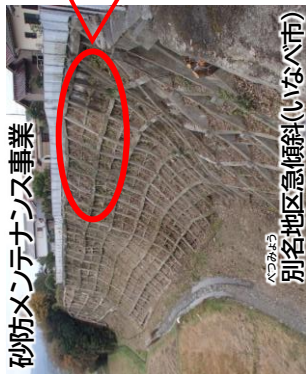
急傾斜の修繕(法格内土砂流出)
