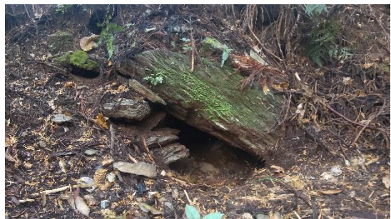
図 54 ③地点の近世石製暗渠(西から)
