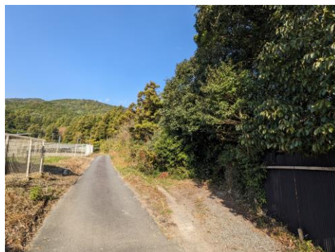
図 64 柳原側からみた未舗装道路
