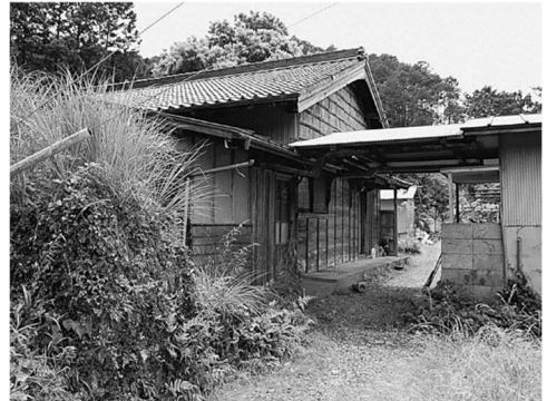
図 146 江戸屋跡の建物(解体)と熊野道
