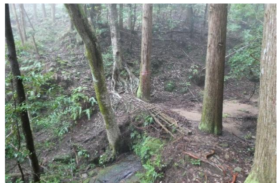
図113 観音道 波田須側(4) 土橋
