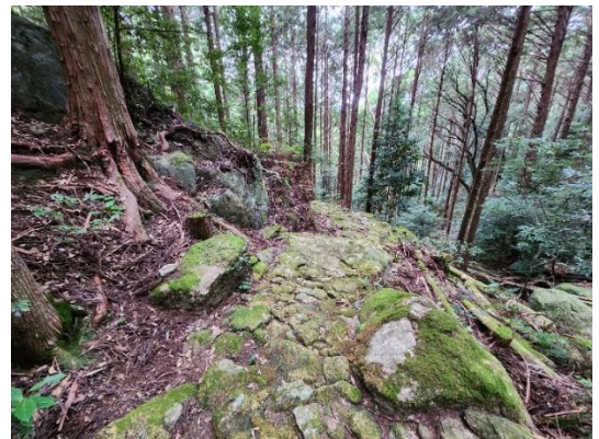
図 117 観音道 岩盤を削平した路面と石畳
