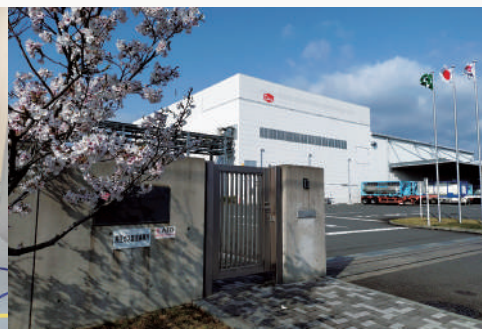
正門からみた三重工場の外観
