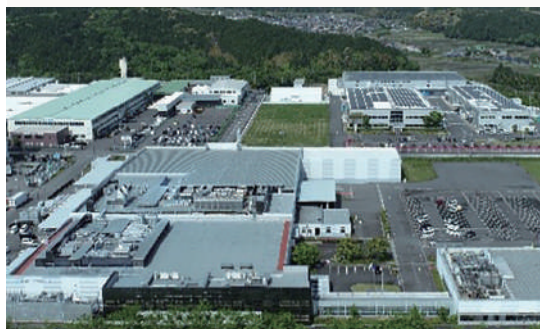
空から見た工場の様子
