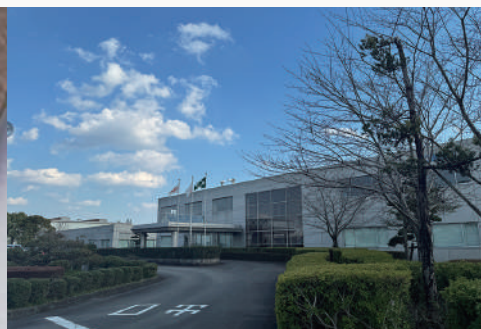
大安製造所 建屋の外観
