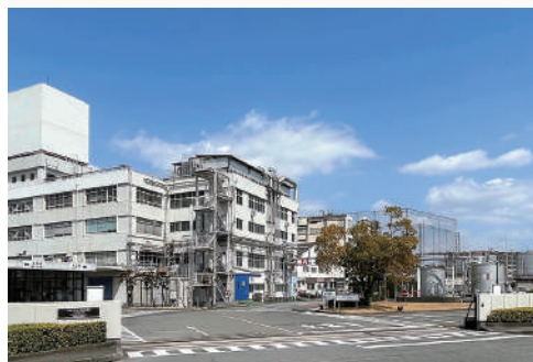
四日市工場外観
