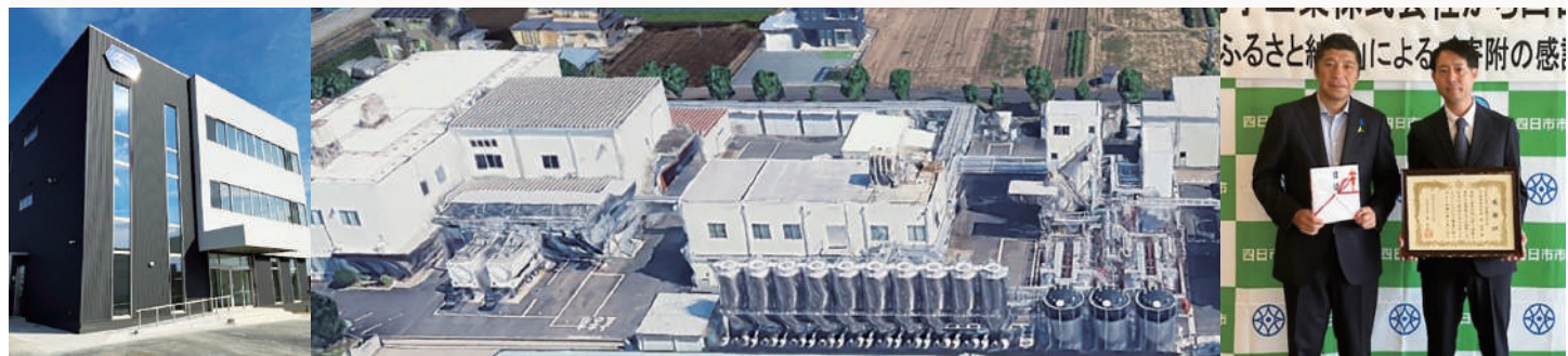
管理棟（2025年11月完成）
