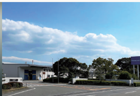
四日市南工場外観
