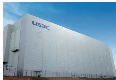
三重工場の外観
