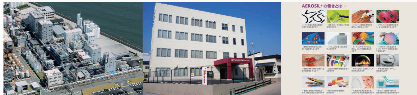
空から見た工場全体
