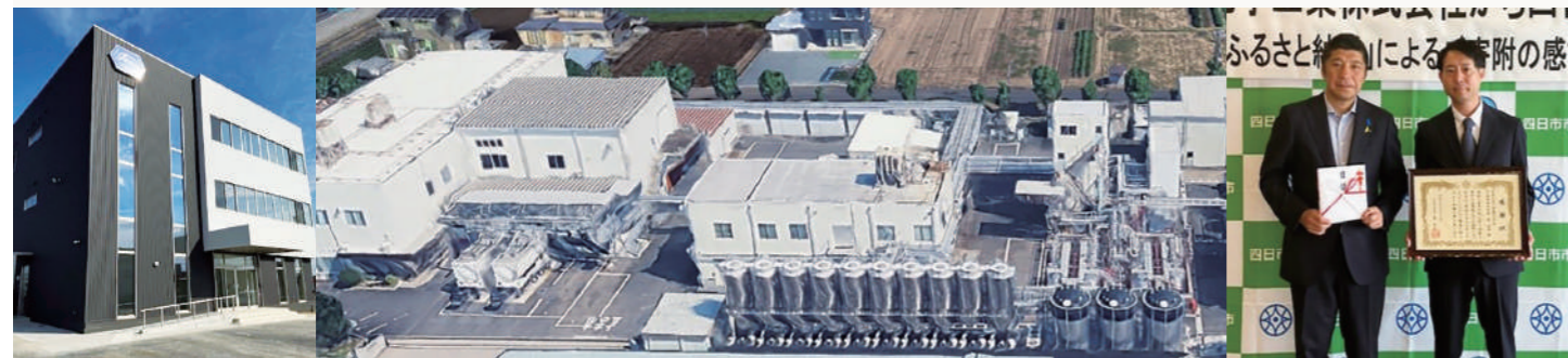
管理棟（2025年11月完成） 工場の全体写真
