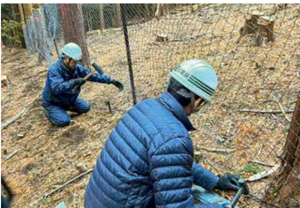
地面へのアンカー、根張りへの又釘の打ち込み
