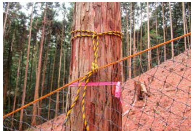
立木と上張りロープの固定（完成）
