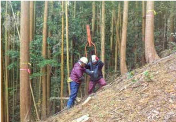
立木間への補助支柱の打ち込み
