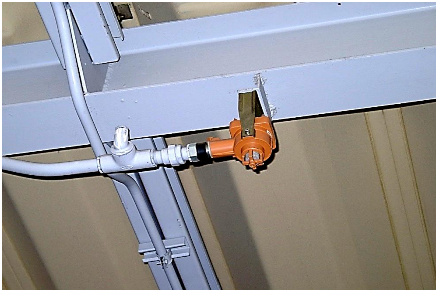
可燃性ガス漏えい検知部
