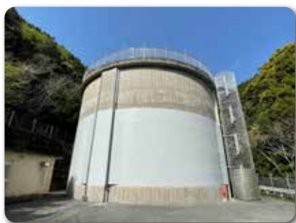
調整池の耐震補強
