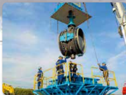
制水弁取替工事の施工状況
