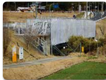
塗装塗替中の水管橋
