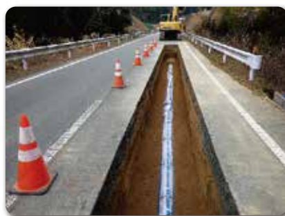
耐震管への布設替え
