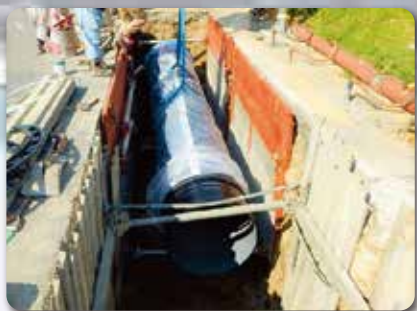
配水管布設替工事の施工状況
