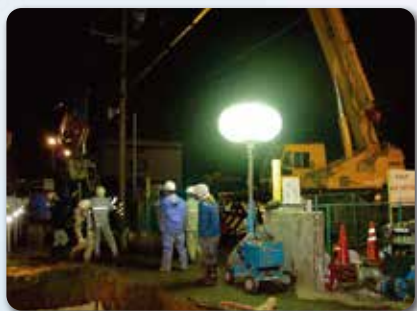
夜間の漏水復旧作業
