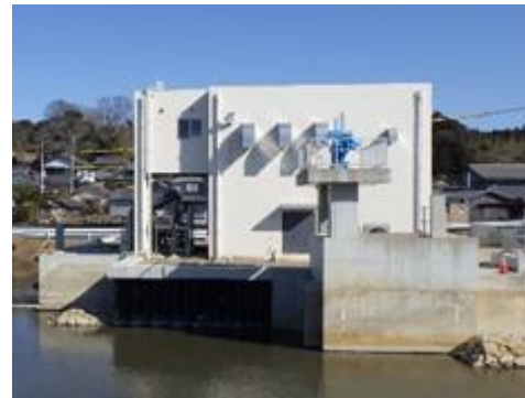
農村地域防災減災事業（令和4年度完成） (三重県：磯部川水系)
