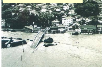
国道167号 灰原橋付近
