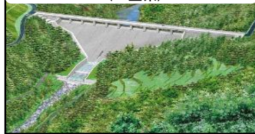
排水機場整備 (三重県)
