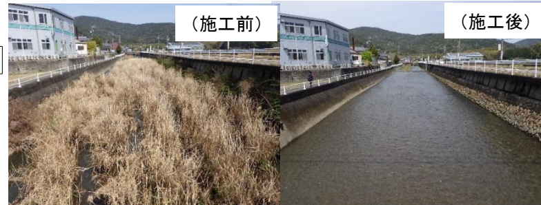
磯部川緊急浚渫推進事業 （三重県）
