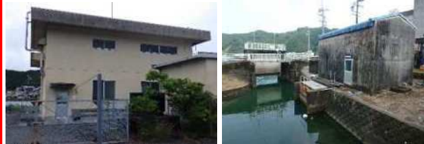
山本地区排水機場 (排水機場整備)【三重県】
