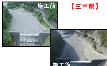
砂防堆積土砂撤去事業(三戸川) 【三重県】
