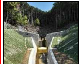
砂防堰堤の整備(名柄川支川1) 【三重県】
