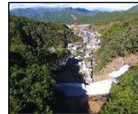
砂防堰堤の整備(猿谷) 【三重県】
