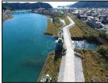
堤防強化事業(船津川) 【三重県】
