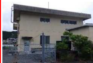
山本地区排水機場 (排水機場整備)【三重県】
