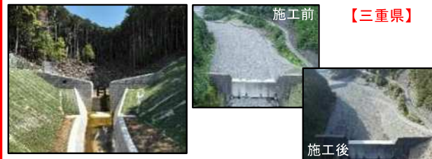
砂防堰堤の整備(名柄川支川1) 【三重県】
