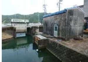
汐ノ津呂排水機場 (排水ポンプ増設)【紀北町】
