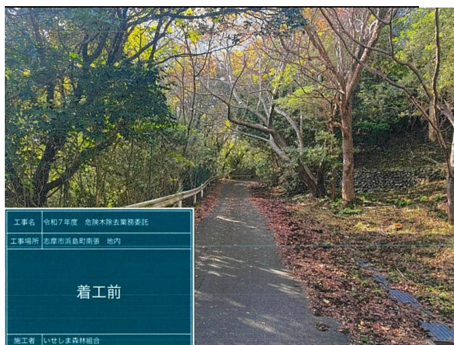
伐採箇所終点付近（作業前）
