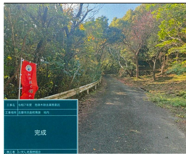
伐採箇所終点付近（作業後）
