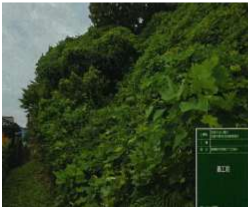
笹尾地区着工前
