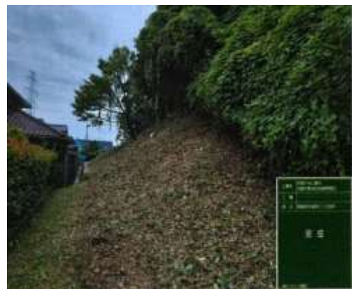
笹尾地区着工後
