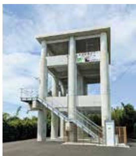
津波避難タワー（志摩市国府地区）
