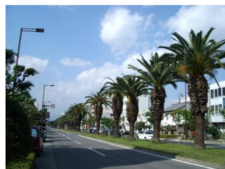
街路樹による良好な道路景観
