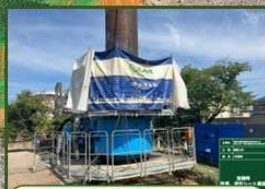
溶接時防風・遮光シートの活用
