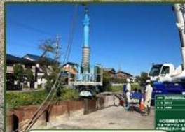
水飛散防止カバーの設置
