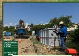
杭精度管理システムの使用
