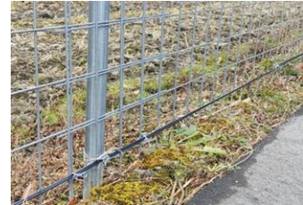
樹脂ワイヤーによる補強
