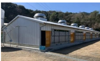
整備した鶏舎
