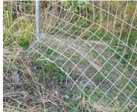
イノシシの押し上げ による柵の破損
