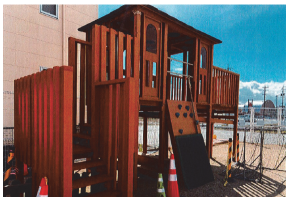
＜保育所等木製遊具購入補助事業＞ 木製遊具の設置
