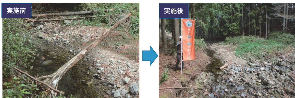
<対策区分1：土砂や流木による被害を出さない森林づくり> 流倒木撤去事業（大紀町）
