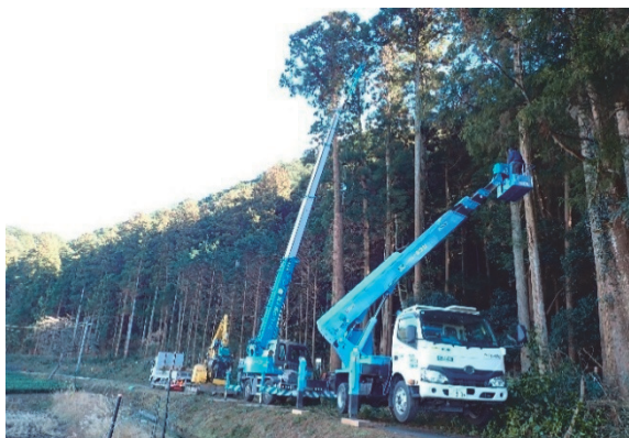
＜危険木伐採事業＞ 伐採作業
