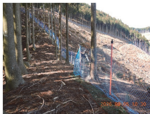
<森林再生力強化対策事業> 獣害防護柵設置による獣害対策
