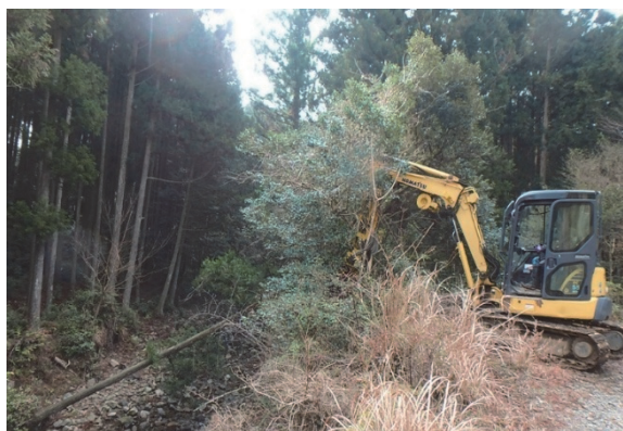
＜溪流倒木等処理事業＞ 溪流内流木の除去
