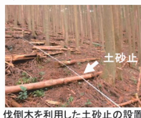
伐倒木を利用した土砂止の設置
