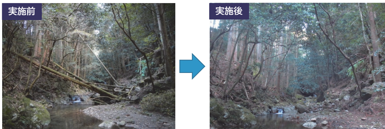
<事業実施状況> 溪流部の対策（津市河内谷ほか）
