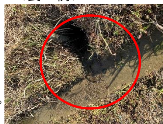
排水口と明渠がつながっている
