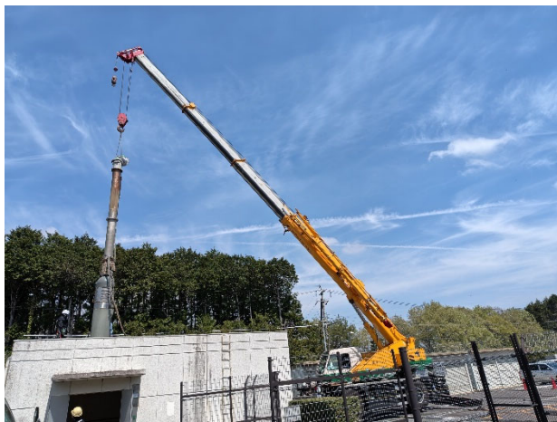
分解点検中の高野浄水場 送水ポンプ設備（津市）
