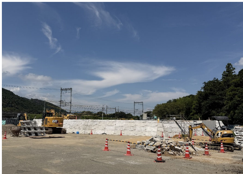
高野浄水場の取水沈砂池浸水対策工事の施工状況（津市）
