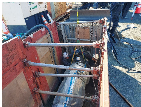
配水管布設替工事の施工状況（鈴鹿市）
