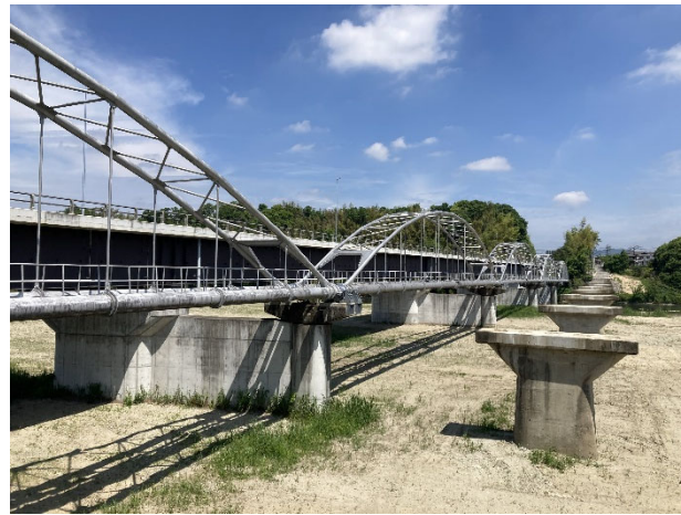
塗り替え予定の雲出川水管橋（津市）
