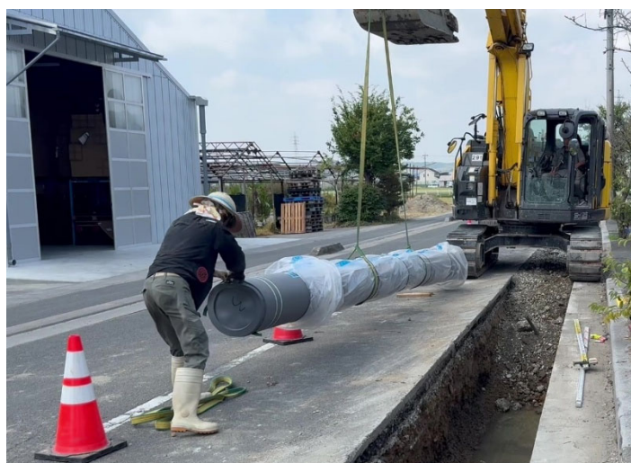
送水管布設替工事の施工状況（桑名市）
