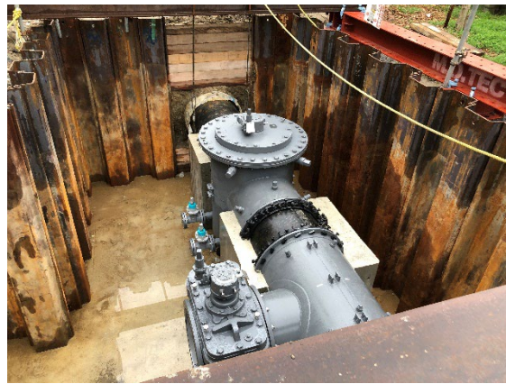
不断水工法*による制水弁設置状況 （四日市市）
