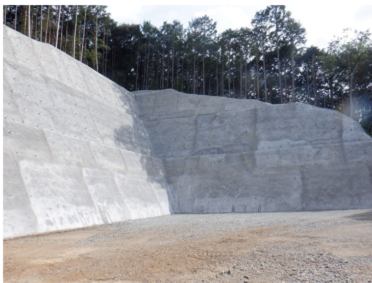
敷地造成が完了した長谷調整池築造予定地（多気町）
