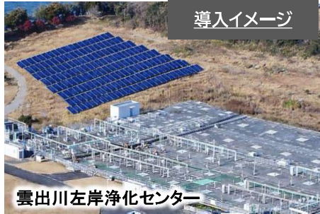
下水処理場内に太陽光発電施設を設置 (自家消費型)
