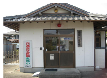
施設整備の例・建替前 （伊勢署宮本駐在所）
