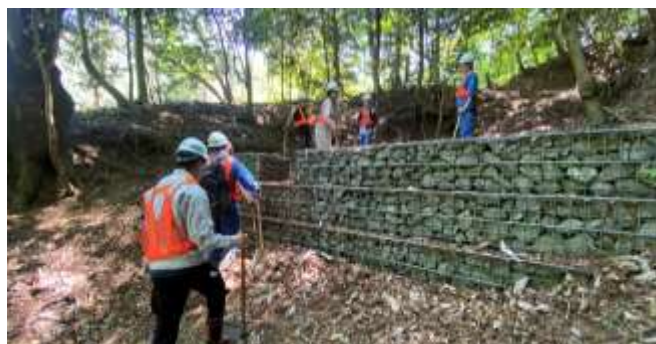
治山施設点検の様子
