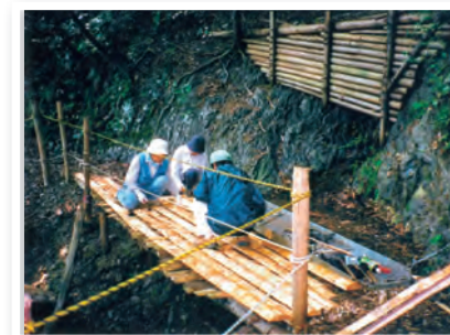
始神峠の橋の整備の様子
